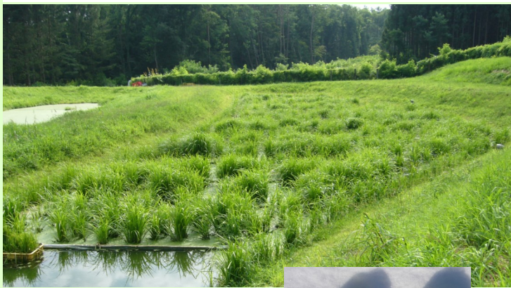
↑ 浸透水平流式人工湿地
