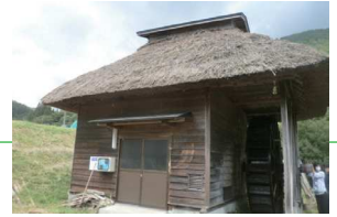
水車小屋全景
