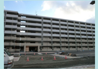
災害公営住宅
