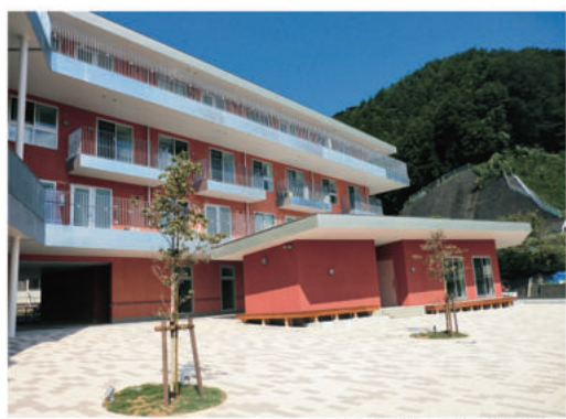
釜石市復興公営住宅天神町
