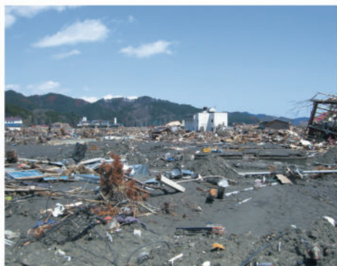
釜石市鞠住居町の被災状況
