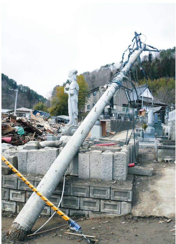
多くの情報通信網が破壊された被災地
