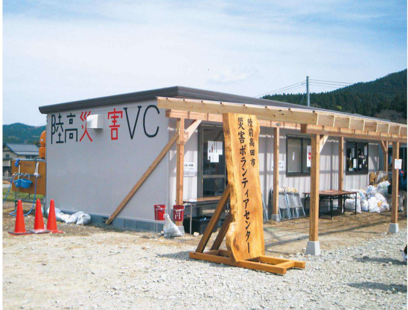
多くのボランティアの受入拠点となった陸前高田市災害ボランティアセンター
