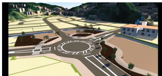
図 4：鉾ヶ崎地区ロータリー交差点付近の景観
