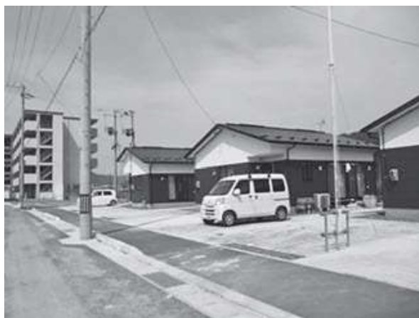
市営鵜住居復興住宅（釜石市）
