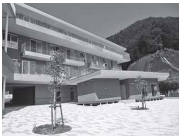
市営天神復興住宅（釜石市）
