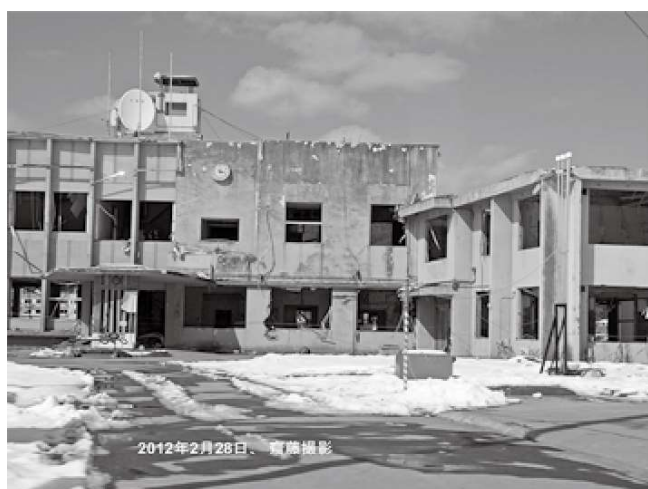
写真6 大槌町役場旧庁舎
