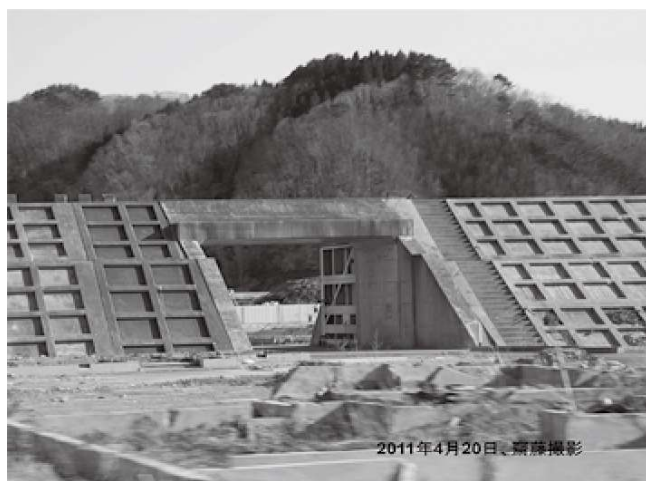
写真3 宮古市田老の防潮堤
