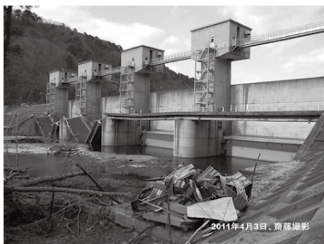
写真4 普代村の普代水門
