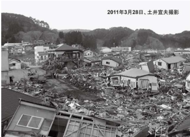
写真2 破壊された宮古市田老の住宅
