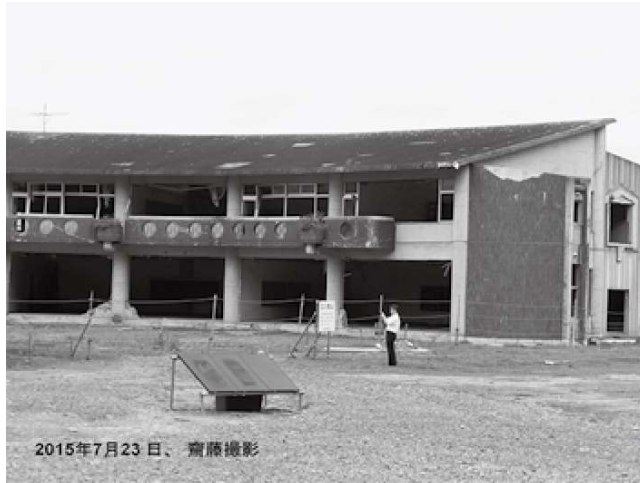
写真5 大川小学校の校舎
