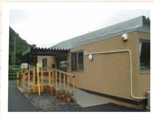
仮設住宅の見守り拠点となる大槌町サポートセンター「和野つなみ」。
