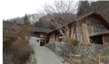
三陸駒舎/釜石市橋野地区の古民家を改修して活動が模索・展開される。各種活動と共に、地域住民、県内外各世代交流の場が育ちつつある。
