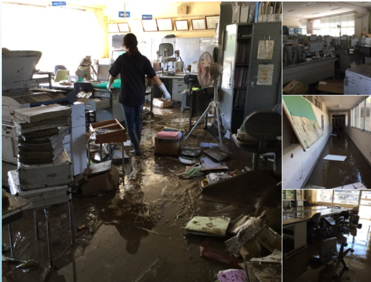
岩手県立宮古高等技術専門校の被害
