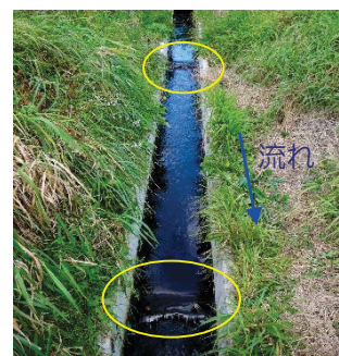
図3 隔壁の設置
