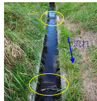
図3 隔壁の設置
